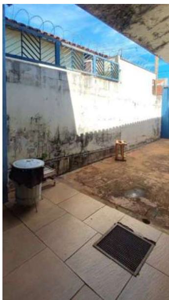
Foto: Parede externa
