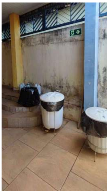
Foto: Parede externa
