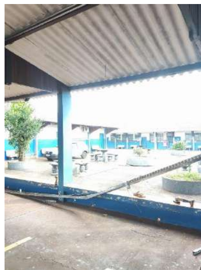
Figura: Retirada das eletrocalhas
