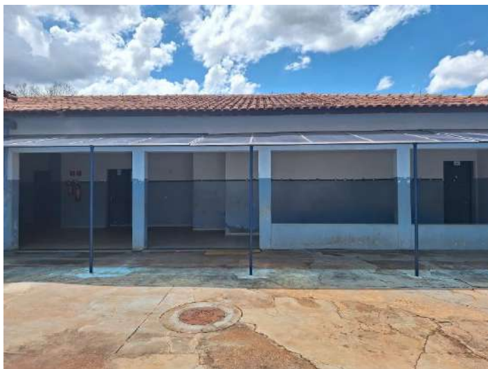
Figura: Toldos instalados
