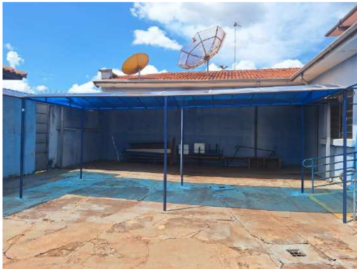
Figura: Sombrites instalados
