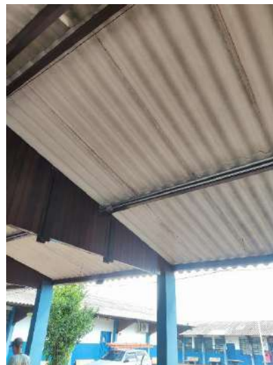
Figura: Eletrodutos instalados
