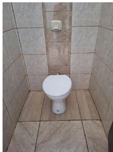
Figura: Banheiro feminino
