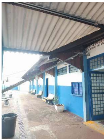
Figura: Retirada das eletrocalhas
